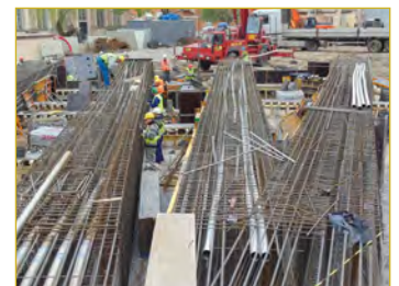
KABLOBETONOWY STROP TRANSFEROWY
