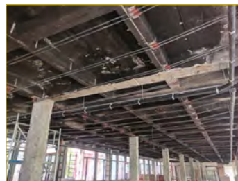
WZMOCNIENIE CIĘGNAMI ZEWNĘTRZNYMI
