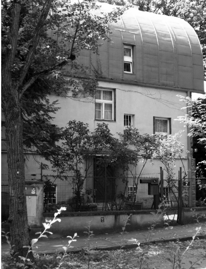
Ryc. 4. Adolf Loos, „Haus Horner” - dom przy Nohartgasse 7, Wiedeń, Austria, 1913; fot. autor
