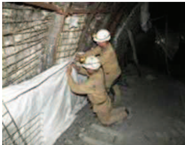
Rys. 1. Sposób zastosowania tkaniny podsadzkowej [5]
