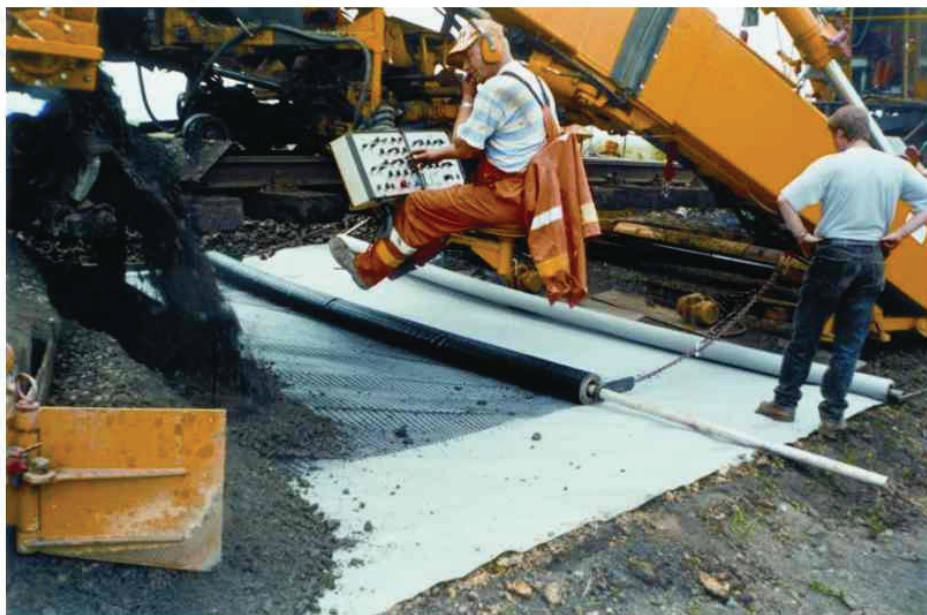
Rys. 2. E30 Lewin Brzeski-Łosiów, geowłóknina Fibertex® F650 M i geosiatka Fortrac®80/80-30, 2000, Fot. INORA
