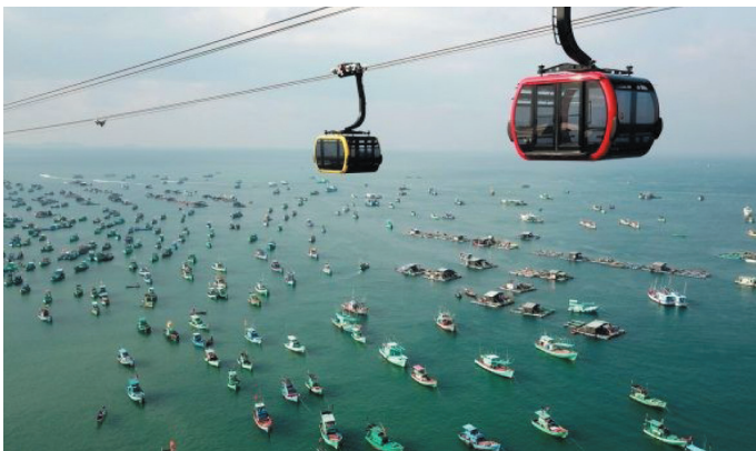
Fot. 6. Kolej linowa typu TGD
