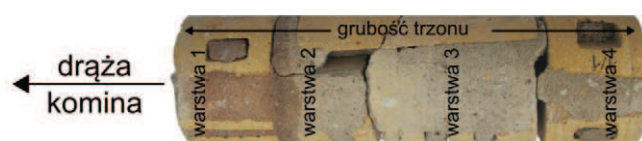
Rys. 3. Odwiert z trzonu komina murowanego
