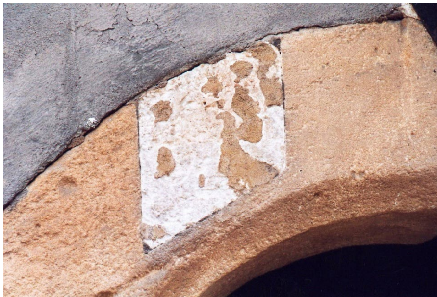
Ryc. 3. Efekt wizualny uzupełnienia ubytków niewłaściwie dobranym materiałem (fot. archiwum autorów)
