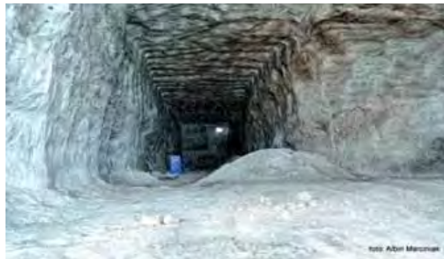
Rys. 3. Wymiary komory: 15 m wysokości i szerokości, 200 m długości. Kopalnia soli „Kłodawa” [4].
