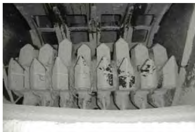
Rys. 4. Wnętrze kruszarki Brieden z widocznymi zanieczyszczeniami.
