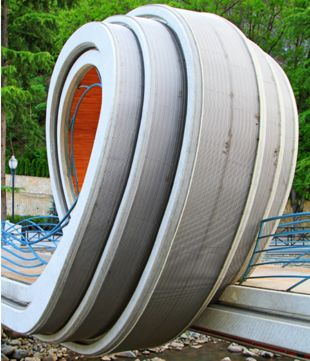
Betonowa kładka dla pieszych w kształcie spinacza w Bordzomi w Gruzji, przykład konstrukcji symbolu miasta, fot. nbi medla
