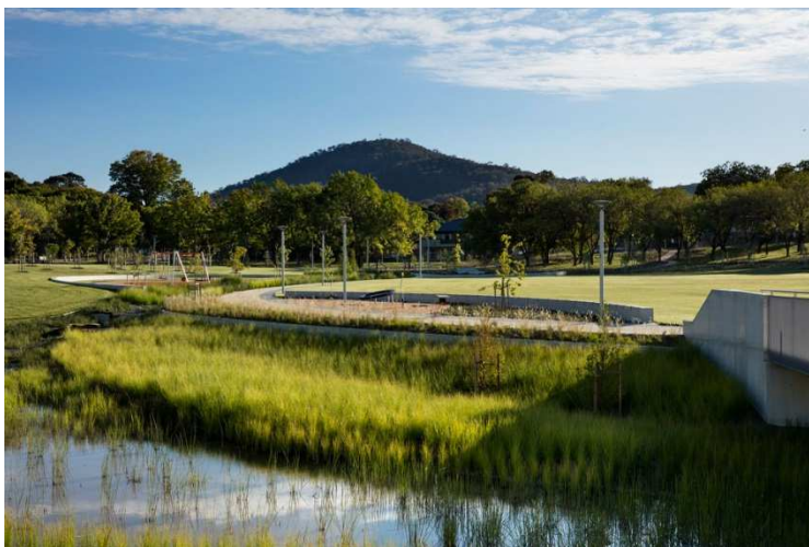
Rys. 9. Zbiornik infiltracyjny zlokalizowany na terenie parku rekreacyjnego, na podstawie [22]
