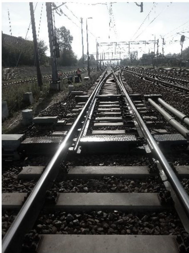
Rys. 6. Rozjazd nr 1 na stacji Siedlce Rzp 1: 12-500-60 E1 z PPP
