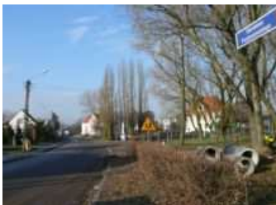
Fot. 14. Przebudowa ul. St. Przybyszewskiego w Inowrocławiu
