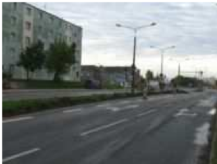
Fot. 8. Remont ul. Roosevelta w Inowrocławiu
