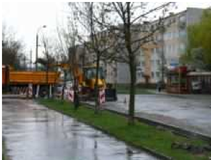
Fot. 3. Remont ul. Krzywoustego w Inowrocławiu Źródło: [6]
