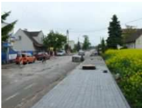
Fot. 15. Przebudowa ul. St. Przybyszewskiego w Inowrocławiu
