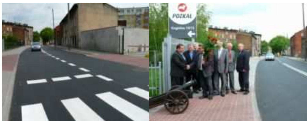
Fot. 18. Przebudowa ul. Cegielnej Fot. 19. Przebudowa ul. Cegielnej Źródło: [11]
