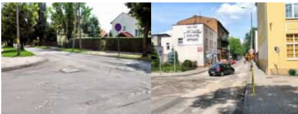
Fot. 20. Remont ul. Średniej i Toruńskiej
