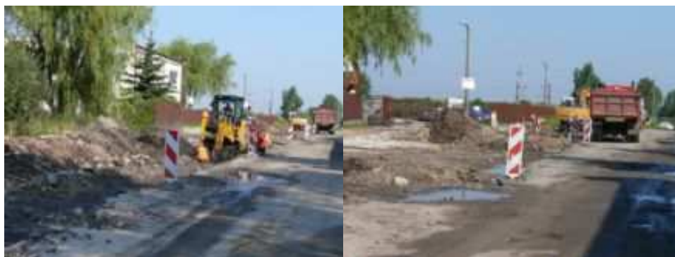
Fot. 12. Przebudowa ul. Karola Marcinkowskiego
