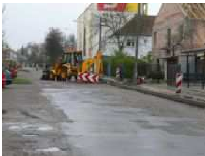
Fot. 4. Remont ul. Krzywoustego w Inowrocławiu Źródło: [6]
