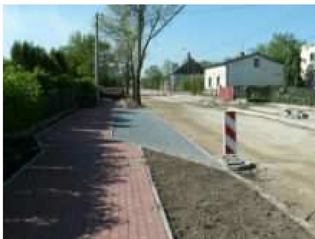
Fot. 27. Remont ul. Rąbińskiej w Inowrocławiu
