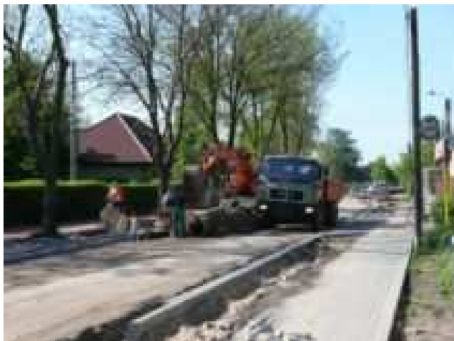
Fot. 26. Remont ul. Rąbińskiej w Inowrocławiu
