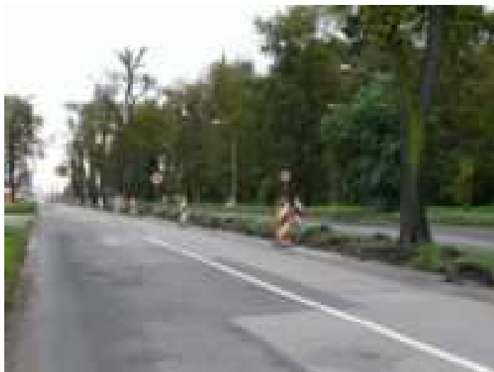
Fot. 9. Remont ul. Roosevelta w Inowrocławiu
