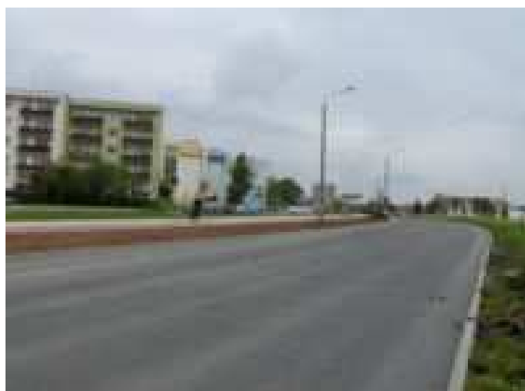
Fot. 6. Przebudowa drogi na ul. Al. Niepodległości Źródło: [7]
