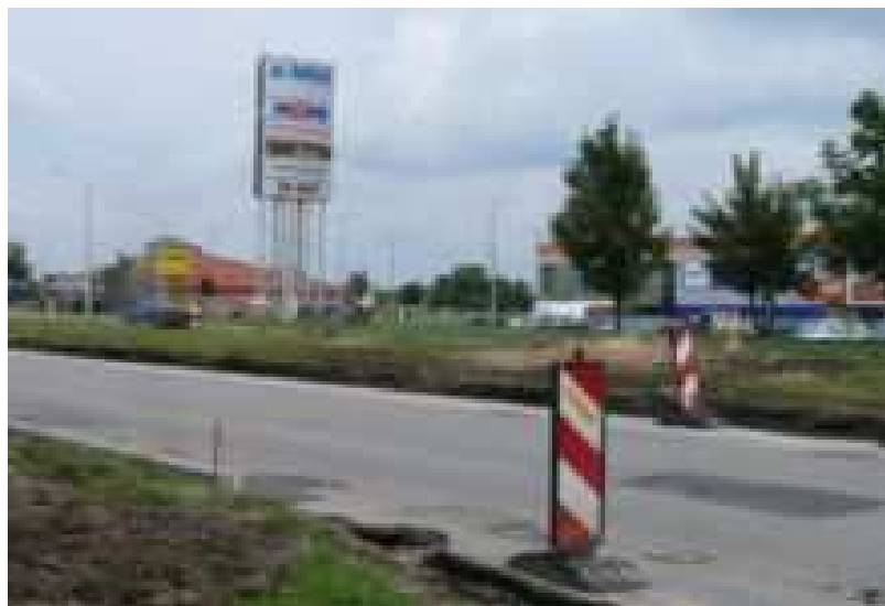
Fot. 5. Przebudowa drogi na ul. Al. Niepodległości Źródło: [7]
