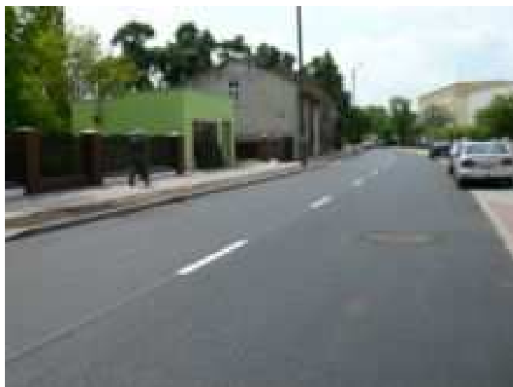
Fot. 17. Przebudowa ul. Cegielnej Źródło: [11]
