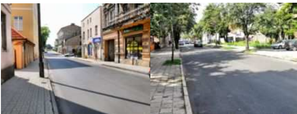
Fot. 22. Remont ul. Średniej i Toruńskiej
