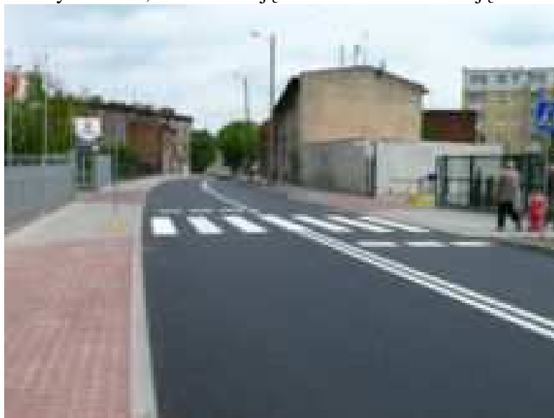
Fot. 16. Przebudowa ul. Cegielnej
