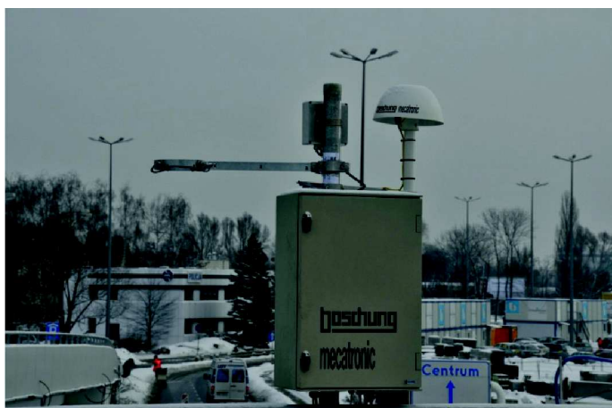
Fot. 6. Na pierwszym planie widoczna stacja meteorologiczna wyposażona w aktywny czujnik stanu nawierzchni. W tle, po lewej stronie widoczna jest estakada wyposażona w głowice spryskujące. Zdjęcie wykonano podczas prac montażowych [19]
