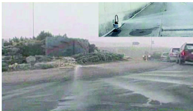
Fot. 2. Przykładowe zastosowania bocznych dysz spryskujących (tzw. głowic), dyszę w powiększeniu oraz fragment zrealizowanego projektu systemu FAST [18]
