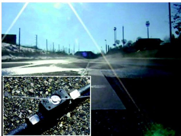
Fot. 3. Mikrodysze spryskujące przed montażem oraz po umieszczeniu w nawierzchni, a także sposób rozpylania środka odładowającego [18]
