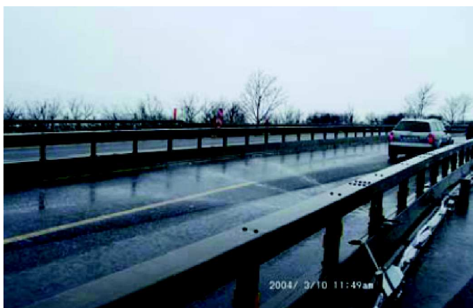
Fot. 4. Widok systemu zraszającego zamieszczonego w raporcie COST 353-2008 [5]
