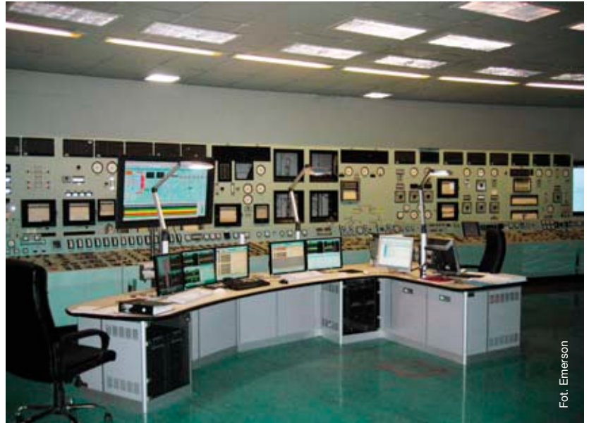
Stanowisko symulacyjne w Elektrowni Fawley umieszczone w nieczynnej nastawni
