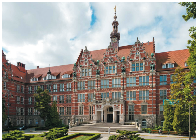
Rys. 5. Obecny widok Gmachu Głównego
