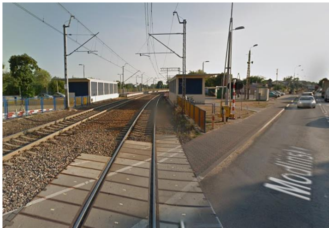
Rys. 6. Przejazd kolejowy w miejscowości Pomiechówek w ciągu drogi krajowej nr 62 i linii kolejowej nr 9. Linia kolejowa przebiega w łuku poziomym, prędkość pociągów została ograniczona z uwagi na przechyłkę w torach. [6]
