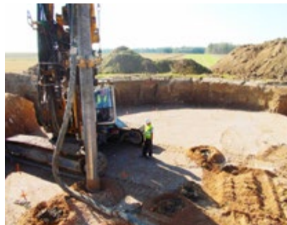
Ryc. 8. Wykonywanie kolumn CMC
