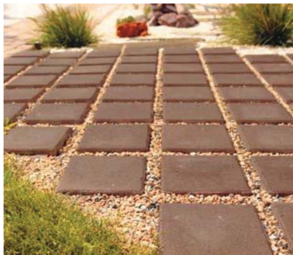
Fot. 1. Nawierzchnia z kostki betonowej z wypustkami dystansującymi [31]
