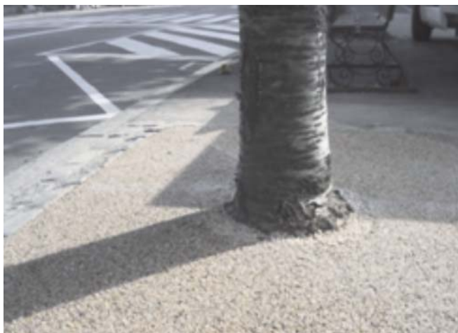
Fot. 4. Nawierzchnia mineralno-żywniczna wykonana nad korzeniami drzewa przyulicznego [14]
