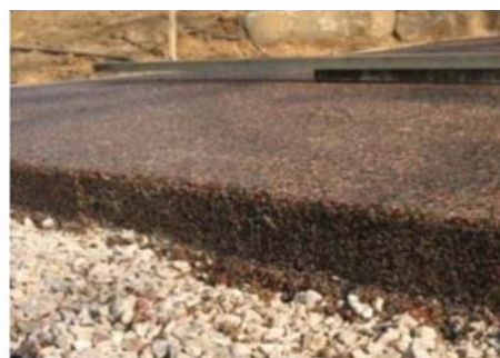
Fot. 8. Budowa nawierzchni z recyklingowanego szkła [28]
