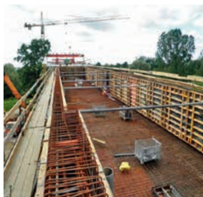
Ryc. 4. Zbrojenie i deskowanie przęsła skrajnego F–G przed betonowaniem I etapu
