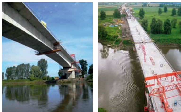
Ryc. 11. Widok na segment zwornikowy D–E tuż przed uciągnięciem całości konstrukcji mostu
