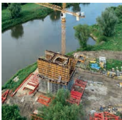
Ryc. 3. Widok na segment startowy D przed betonowaniem I etapu oraz montaż wózków na segmencie E
