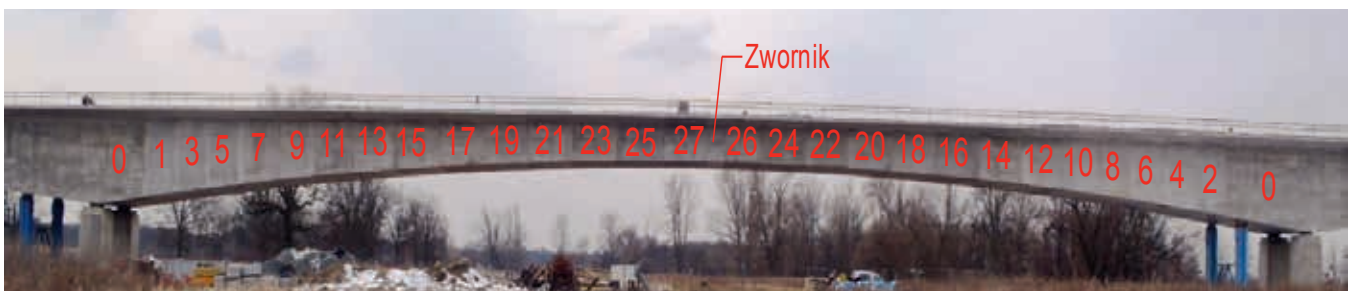
Ryc. 8. Schemat rozmieszczenia segmentów na przykładzie przęsła C-D
