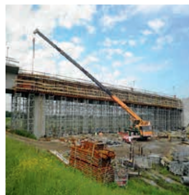
Ryc. 4. Zbrojenie i deskowanie przęsła skrajnego F–G przed betonowaniem I etapu
