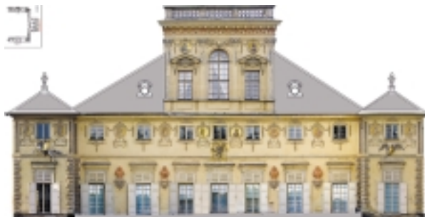
12. Przykład dokumentacji ortofotograficznej bryły pałacu w Wilanowie, fragment fasady od strony ogrodu. Wyk. M. Gładki
