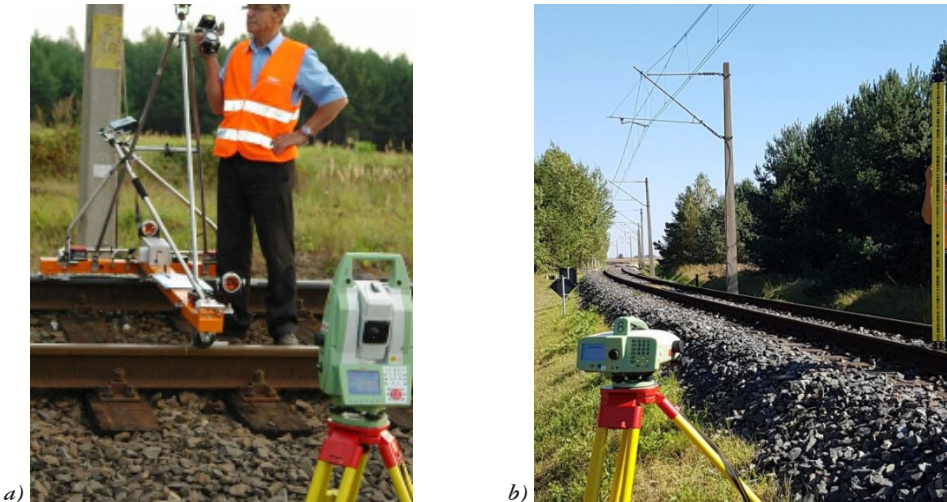
Rys. 1. Tachymetr Leica Nova MS50 (a) oraz niwelator Leica DNA03 w trakcie wykonywania prac pomiarowych na terenie kolejowym
