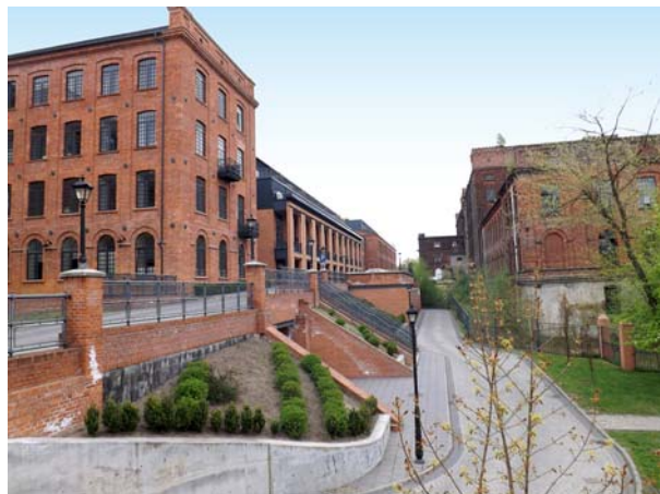
Ryc. 23. Łódź, Księży Młyn, odrestaurowana i rozbudowana szwalnia oraz obiekt wciąż zdewastowany (2016) – fot. M. Gyurkovich
