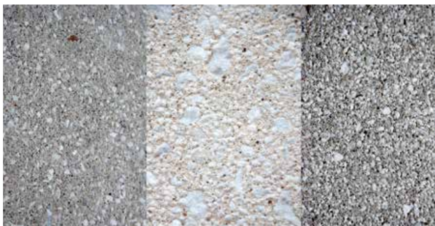
Fot. 9. Różne efekty piaskowania betonu
