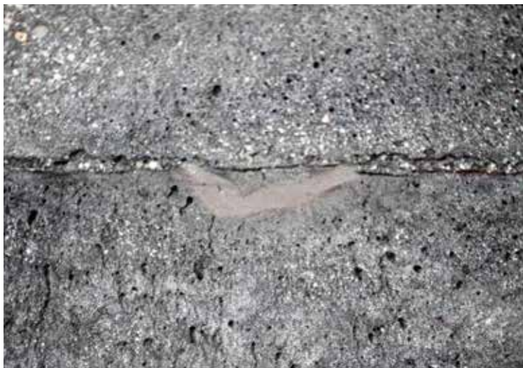
Fot. 5. Naprawa betonu polerowanego barwionego przy użyciu barwnika antracytowego
