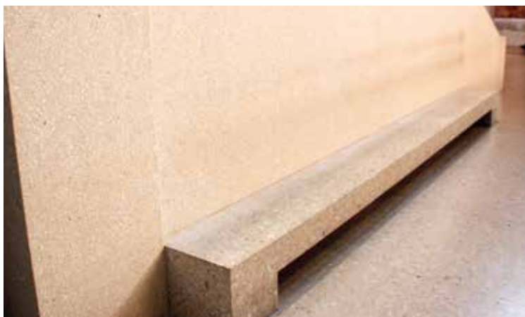
Fot. 12. Połączenie betonu piaskowanego i polerowanego – Neues Museum w Berlinie
