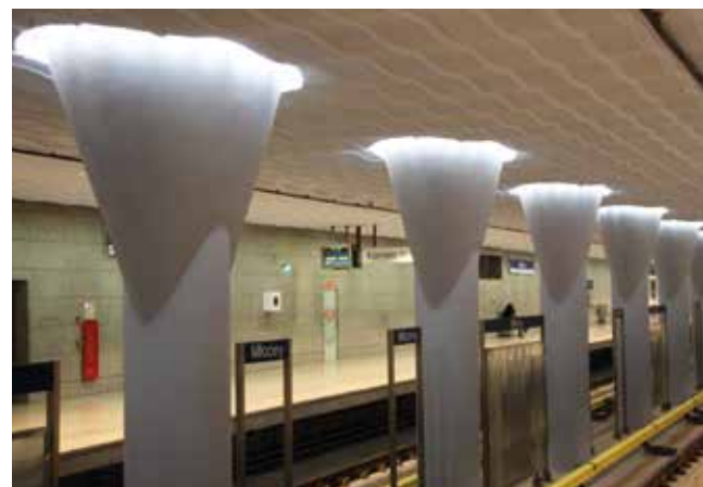
Fot. 7. Zastosowanie cienkowarstwowego barwienia betonu
