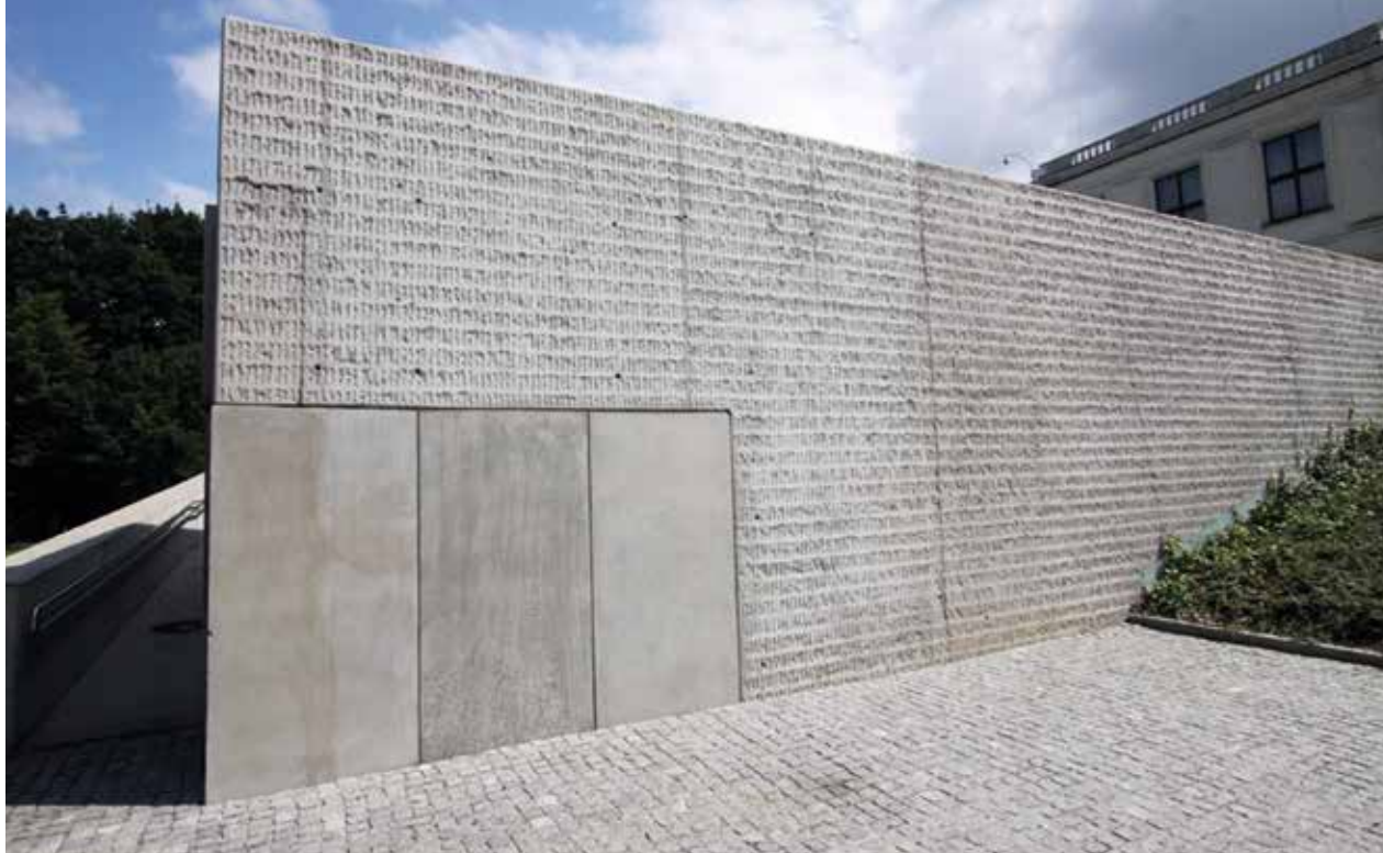
Fot. 11. Powierzchnia młotkowana – Kancelaria Sejmu RP
