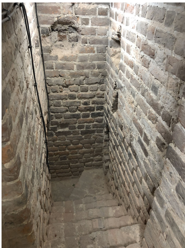
Ryc. 8. Opole, Zamek Górny, wieża bramna, poziom piwnic, schody wzdłuż elewacji południowej, fot. A. Legendziewicz
