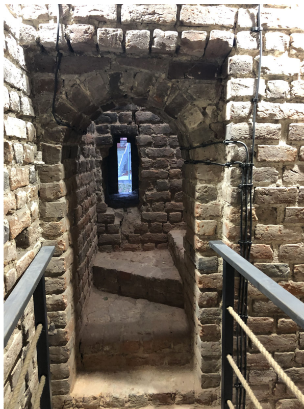
Ryc. 9. Zamek Górny, wieża bramna, poziom piwnic, wejście na schody z pomieszczenia przeciwwagi mostu zwodzonego, fot. A. Legendziewicz
