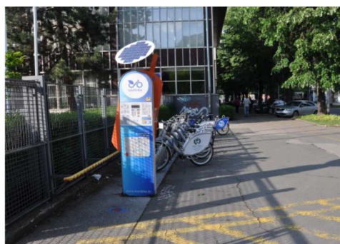
Rys. 10. Fotowoltaika w urządzeniach miejskich. Fot. autor
