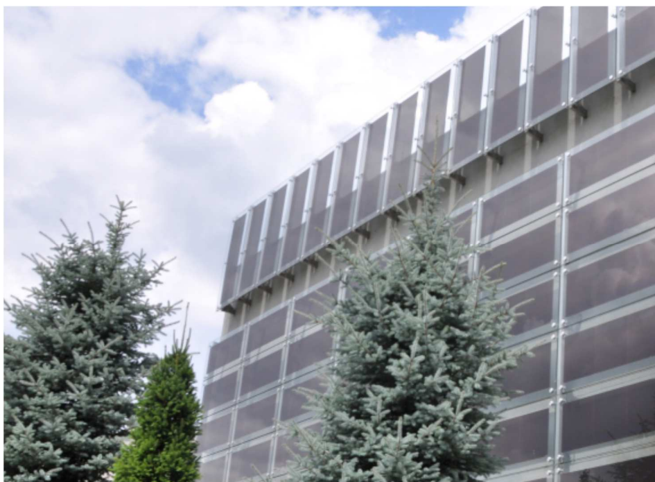
Rys. 6. Fasada z elementami fotowoltaicznymi. Fot. autor
