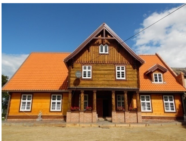
Fot. 4. Dom podcieniowy w Rybinie. (fot. autor)
