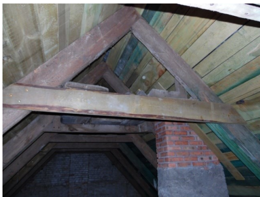
Fot. 12. Rybina – nowa jętką w więźarze po remoncie. (fot. autor)
