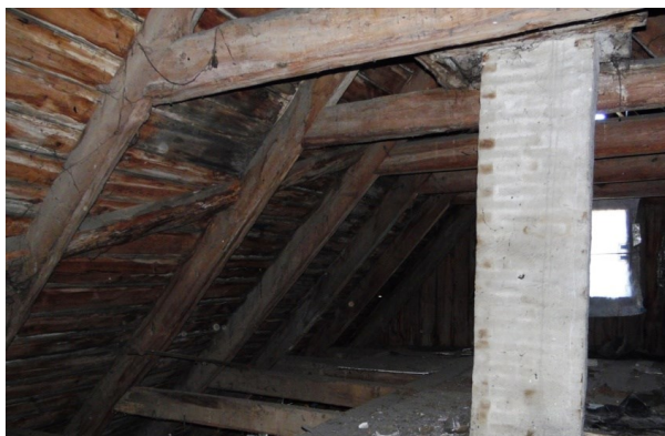
Fot. 7. Marynowy – widok na więźbę, widać dwie jętki
