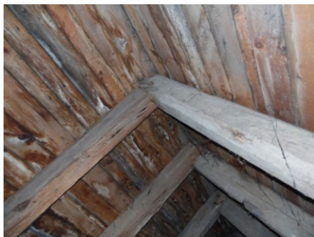
Fot. 9. Nowa Kościelnica – połączenie krokwi. (fot. autor)
