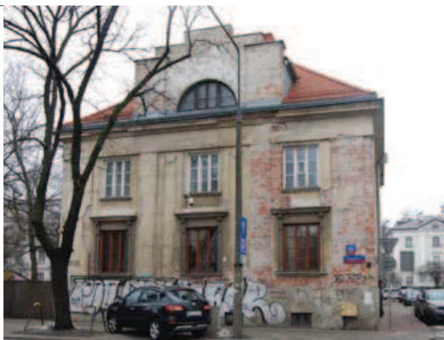
Rys. 1. Przygotowanie elewacji do remontu polegające na zrzuceniu odspojonych oryginalnych tynków, Warszawa, ul. Raszyńska 48, 1928 (fot. M. Korpała 2017)
