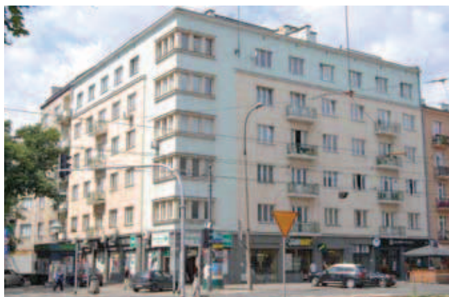
Rys. 7. Elewacja po modernizacji (docieplenie, nowe tynki i kolorystyka), której skutkiem jest nowa ahisteryczna kompozycja kolorystyki, Warszawa, ul. Grójecka 34, proj. Antoni Jawornicki, 1936–37 (fot. J. Lewicki 2015)
