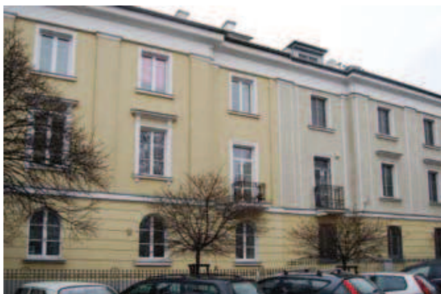
Rys. 8. Elewacja bliźniaczej kamienicy, po odnowieniu przez dwie wspólnoty mieszkaniowe (wykonanie nowych tynków szlachetnych popularnie zwanych „barankiem” i nowej kolorystyki), Warszawa, ul. Mianowskiego 10, 1925 (fot. M. Korpała 2017)
