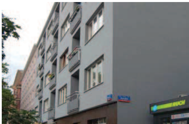
Rys. 5. Elewacja kamienicy po modernizacji (docieplenie metodą lekką suchą, nowe tynki i kolorystyka) spowodowała zmianę plastyki przez wysunięcie górnej części pogrubionej elewacji, Warszawa, ul. Filtrowa 64, proj. Lucjan Korngold, 1935–36 (fot. J. Lewicki 2015)
