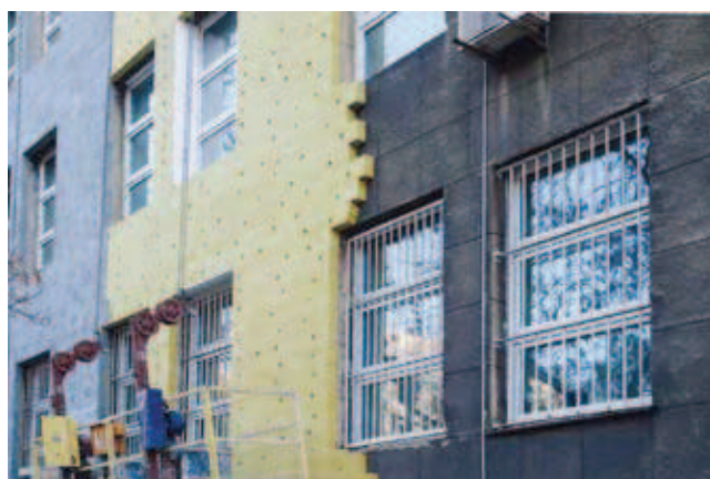
Rys. 4. Elewacja pokryta tynkiem nakrapianym w trakcie termomodernizacji (metodą lekką suchą) – znaczne pogrubienie lica elewacji powoduje zagłębienie okien (fot. J. Lewicki 2009)
