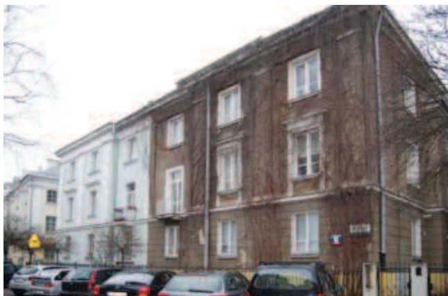
Rys. 9. Elewacja bliźniaczej kamienicy, której tylko połowa została odnowiona (wykonanie nowych tynków i nowej aranżacji kolorystyki) – pozwala ocenić zakres zmian w stosunku do części nieodnawianej, Warszawa, ul. Mianowskiego 12, 1925 (fot. M. Korpała 2017)
