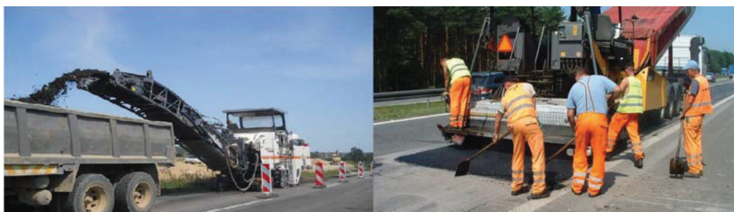
Fot. 1a-1b. Przebieg procesu wymiany warstwy ścieralnej [3, 4]
