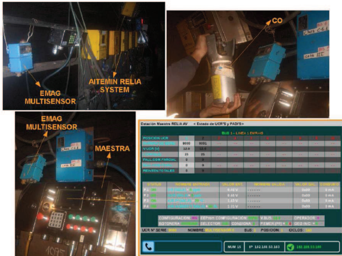
Rys. 26. Podłączenie czujnika DWP-1 do stacji nadrzędnej MAESTRA (EMR-II [14])
