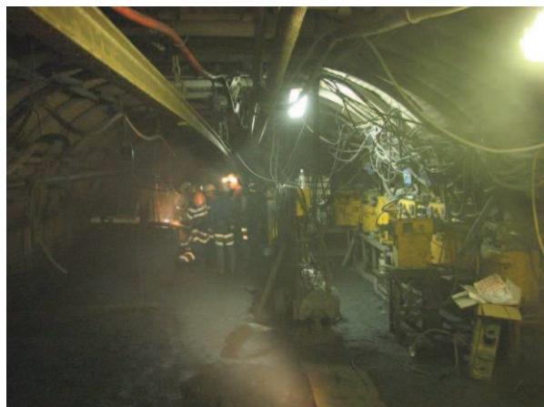
Rys. 21. Widok wyrobiska na końcu taśmociągu przENOŚNIKOWEJ, gdzie przeprowadzany był test zacierania taśmy
