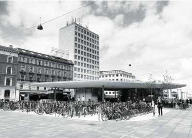
Wejście do stacji Nørreport po przebudowie. Fot. L. Jørgensen, licencja CC BY-SA
