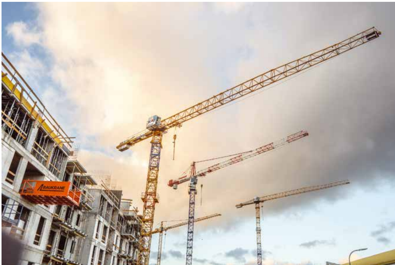
Fot. 1. Praca 4 dźwigów przy realizacji inwestycji Zajezdnia w Gdańsku:
