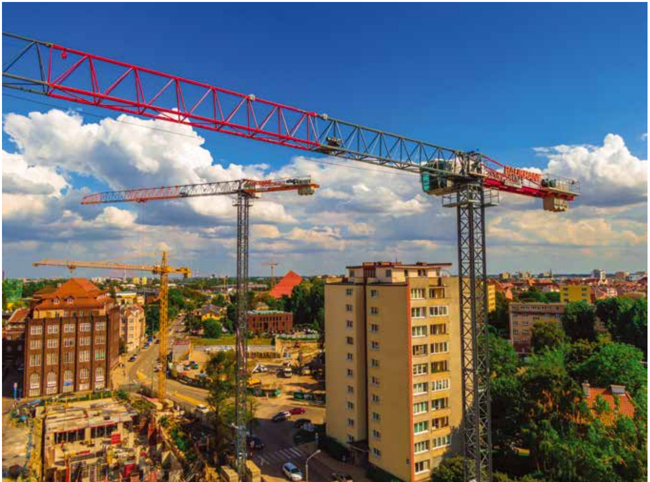
Fot.2. KR-90 na budowie Bastion Wałowa w Gdańsku: • KR-90 – Wysokość 41,1 m, wysięgnik 35,7 m, udźwig 5 t
