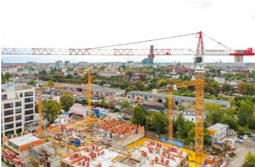
LIEBHERR 132 EC-H 8 Litronic – Wysokość: 45,5 m, Wysięgnik: 55,0 m, Udźwig 8t
