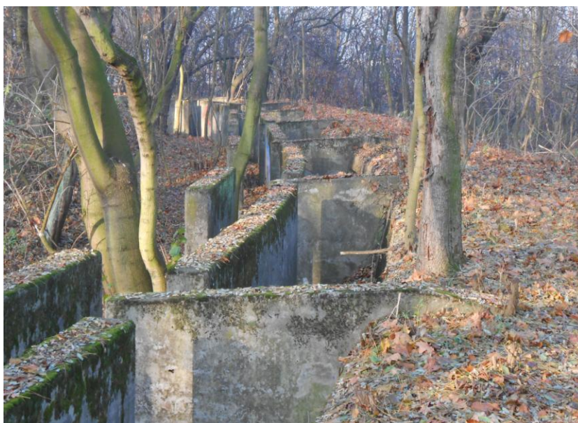
Rys. 3. Betonowa pozycja strzelecka punktu oporu piechoty I.St. 6
