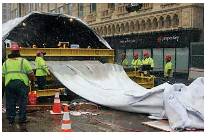
Ryc. 4. Przygotowywanie powłoki CIPP [1]
