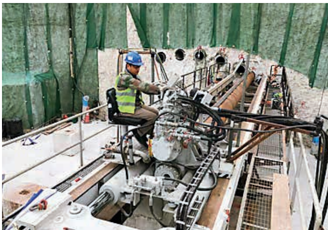
Ryc. 7. Wiertnica firmy Bohrtec pracująca nad łukiem rurowym w Doha [1]
