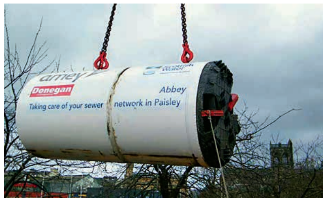
Ryc. 6. Opuszczanie MTBM do szybu startowego [1]
