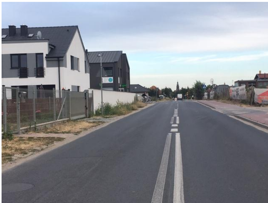
Rys. 10. Zdjęcie ilustrujące brak ładu przestrzennego [A. Kasińska-Andruszkiewicz]
