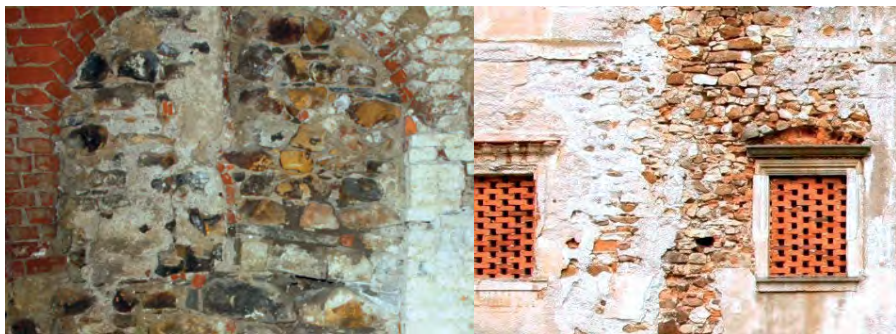
Rys. 5. Mur kamienny dziki i ceglane sklepienia i mur warstwowy, mieszany kamienno-ceglany
