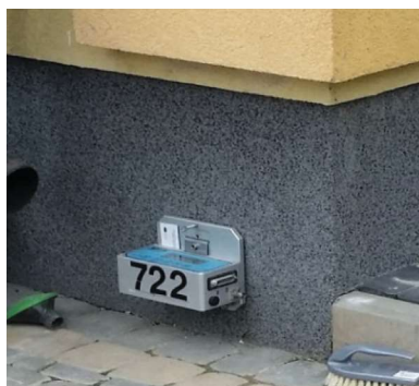
Rys. 4. Wskazane miejsce montażu miernika drgań - w sztywnym węźle na ścianie kondygnacji podziemnej w poziomie otaczającego terenu
