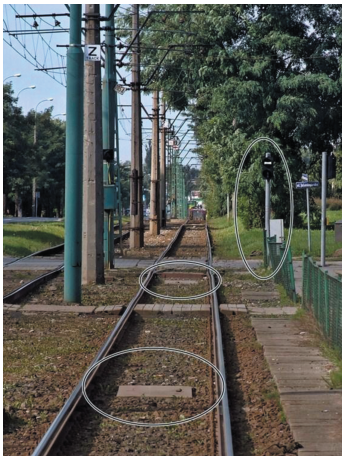
Fot. 3. Układ pętli indukcyjnych na wydzielonym torowisku tramwajowym Źródło: http://tramwaje.gdanskie.info/data/media/181/pozna_grunwaldzka_jeleniogrska_ptle_indukcyjne.JPG
