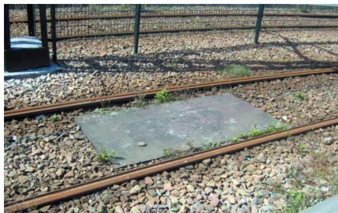
Fot. 2. Pętla indukcyjna na wydzielonym torowisku tramwajowym Źródło: http://www.transportszynowy.pl/sygetplad.jpg
