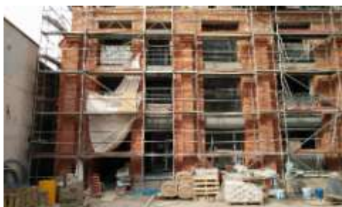
Rys. 2 Wbudowana zabytkowa cegła w nowopowstającą konstrukcję 21.03.2017, archiwum własne
