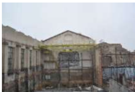
Rys. 1 Obiekt po częściowej rozbiórce, widok pozostawionych fragmentów starej elektrowni, 12.10.2015, archiwum własne
