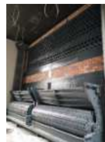
Rys. 3 Dwa odrestaurowane kotły firmy Zieleniewski 28.06.2016, archiwum własne
