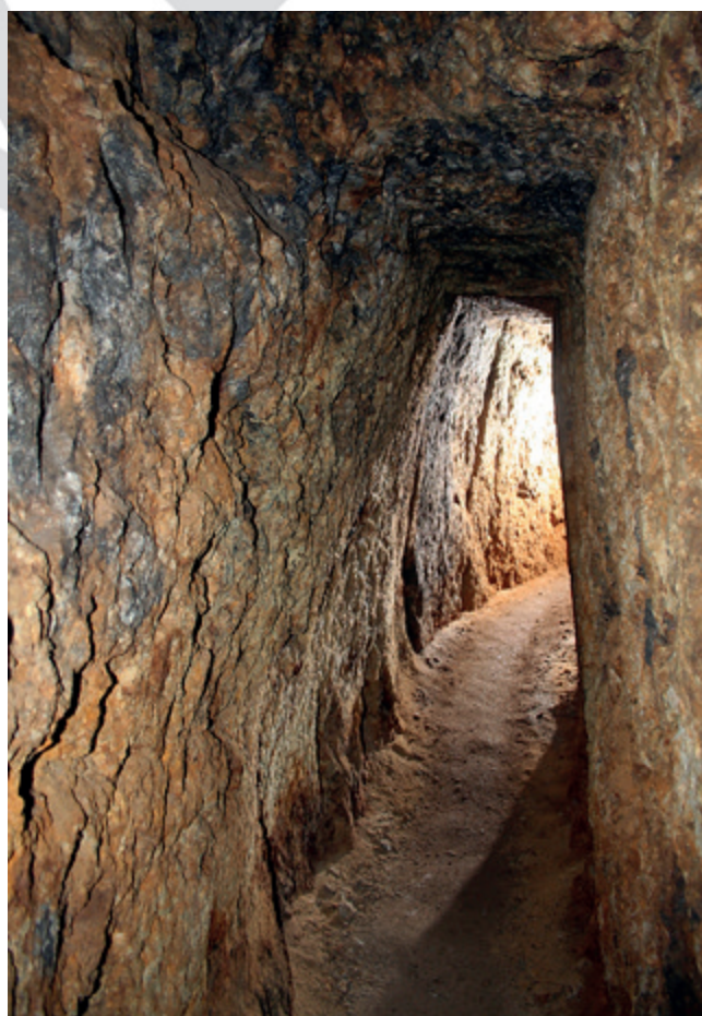
Fig. 20. Medieval hand-drawn galleries “kresanica“ on a tourist route in Starovšechsvätých mine at Hodruša Hámre (Central Slovakia), photo P. Hronček
