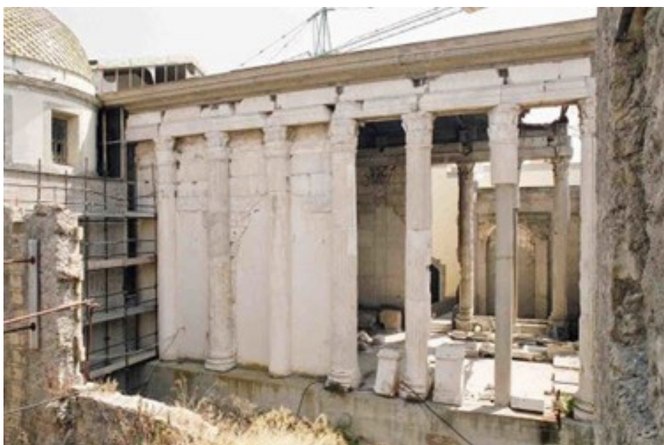
Ryc. 12 Tempio Duomo Rione Terra przed pracami renowacyjnymi, źródło: http://1.bp.blogspot.com/-sq_JcdJgGbw/U5AVyZ0HuoI/AAAAAAAAPRg/mTB15YaN5dM/s1600/fig.+2+--+Esterno+della+cattedrale+di+Pozzuoli.jpg
