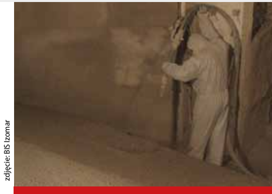
Montaż betonu ogniotrwałego
