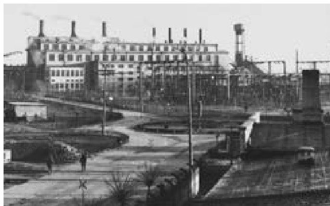
Rys. 4. ESW I po pierwszym etapie rozbudowy, po około 50 latach. [17]
