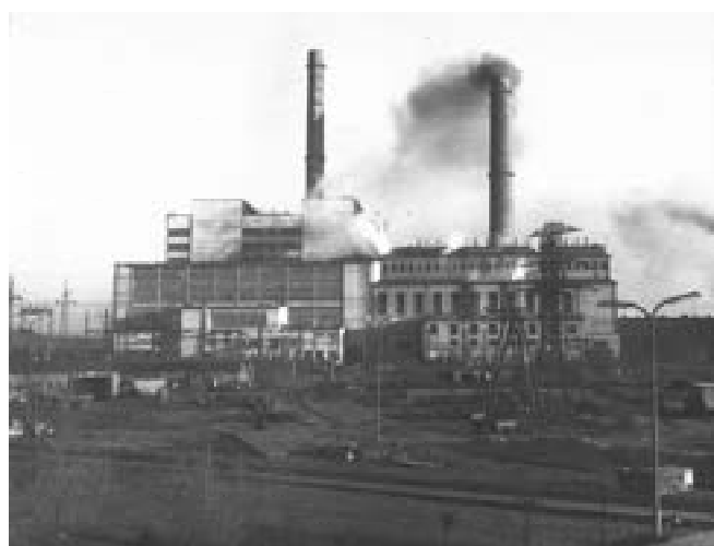
Rys. 6. Od prawej: ESW II i III w budowie, po 1965 r. [17]
