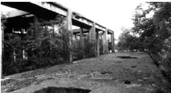
Rys. 3. Nieukończona elektrownia w Stykowie koło Starachowic, bazująca na projektach tożsamyh do ESW, 2018 r. (fot. W. Chudzik) [16]
