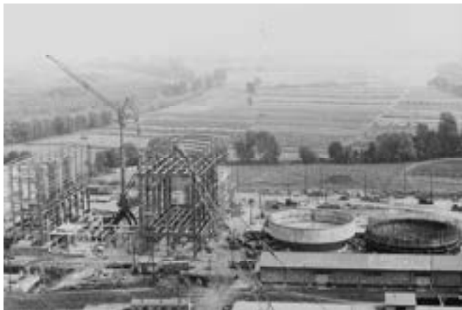
Rys. 7. Budowa czonołowni ciepłowniczej dla Jeziorka, 1977 r. [33]
