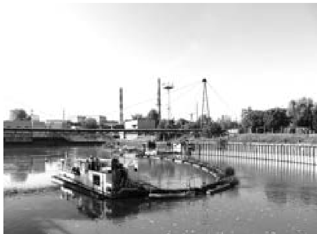
Rys. 8. Widok na Elektrociepłownię Stalowa Wola (ECSW) S.A. i ESW od strony ujścia wody z Sanu. Fotografia współczesna [37]
