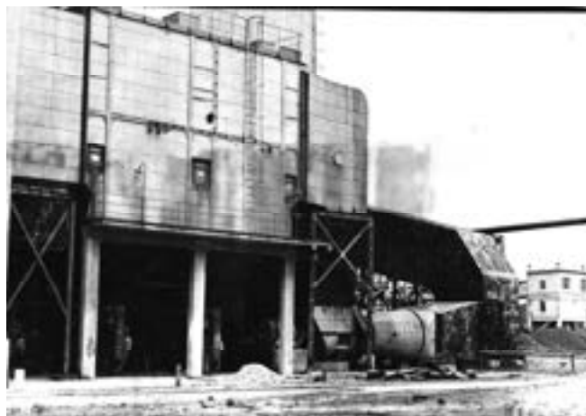
Rys. 9. Fragment elektrofiltra kotła OP-100, lata budowy 1954-1957 [26]
