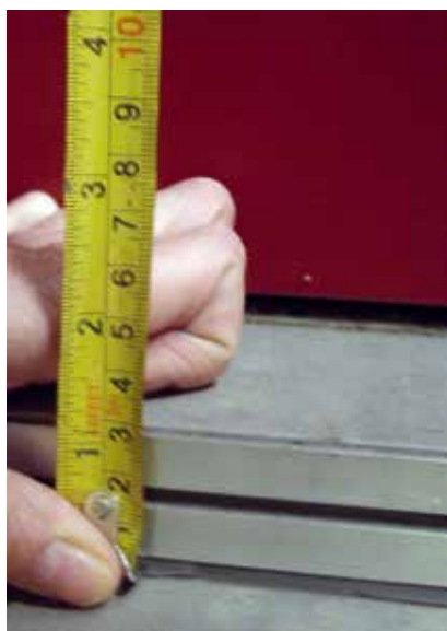
Fot. 4 i 5. Wysokie progi w wejściach do pokoi oraz nieprzystosowane do wymagań dostępności ogólnodostępne pomieszczenie higieniczno-sanitarne w DS. III; źródło: opracowanie własne
