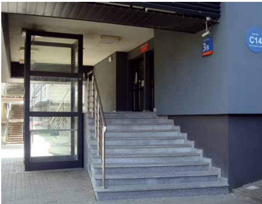
Fot. 1. Platforma pionowa przy wejściu do DS I; źródło: opracowanie własne
