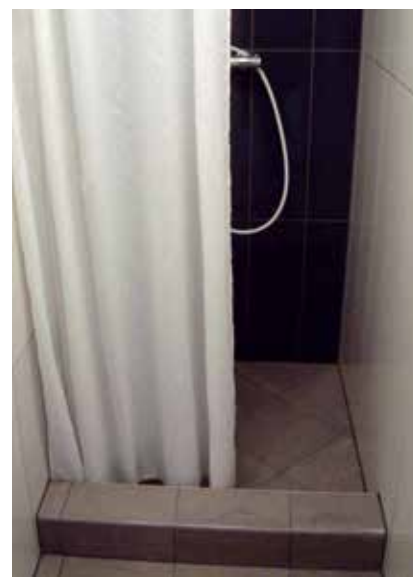
Fot. 4 i 5. Wysokie progi w wejściach do pokoi oraz nieprzystosowane do wymagań dostępności ogólnodostępne pomieszczenie higieniczno-sanitarne w DS. III; źródło: opracowanie własne
