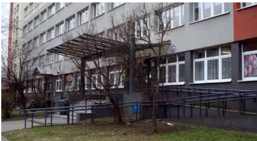
Fot. 2. Pochylnia przy wejściu do DS. IV; źródło: opracowanie własne
