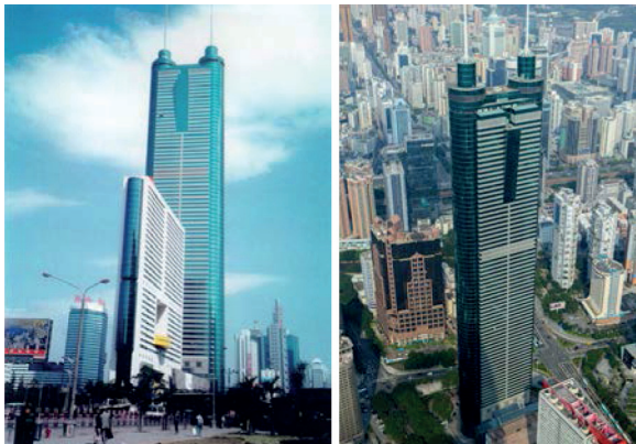
Fig. 1. The Di Wang Tower, Guangdon, China [9]
