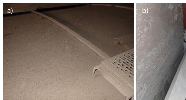
Rys. 5. Widok wierzchu żelbetowego sklepienia kolebkowego SK-2: a) w kluczu, b) w poziomie posadowienia
