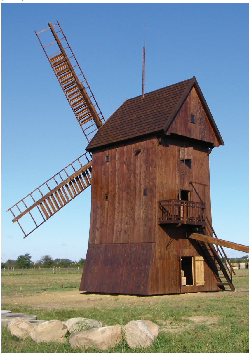
Fot. 2. Wiatrak-koźlak w Lesznie (ul. Osiecka/ul. Popieluski), widok ogólny obiektu po pracach konserwatorskich; fot. F. Tomaszewski, 25.09.2018 r.
