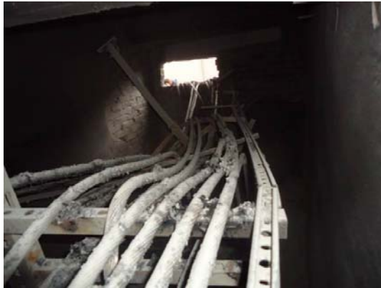
Rys. 10. Tor prądowy po awarii – pożarze
