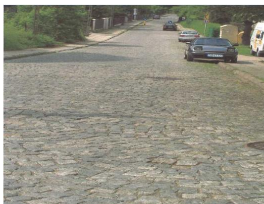
Rys. 8. Droga o nawierzchni brukowanej
