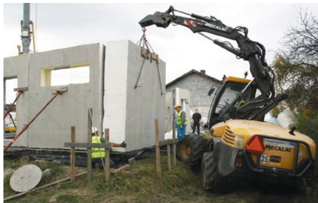
Rys. 1. Montaż przy użyciu żurawia wieżowego
