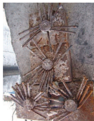
Fot. 1. Widok bloków kotwiących kable sprężające
