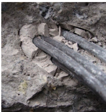
Fot. 2. Widok kanału kablowego wypełnionego iniekcją
