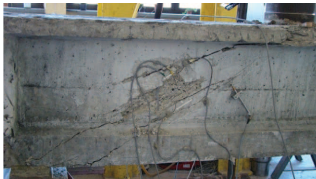
Fot. 3. Widok miażdżonego krzyżulca betonowego, tuż przed utratą nośności belki
